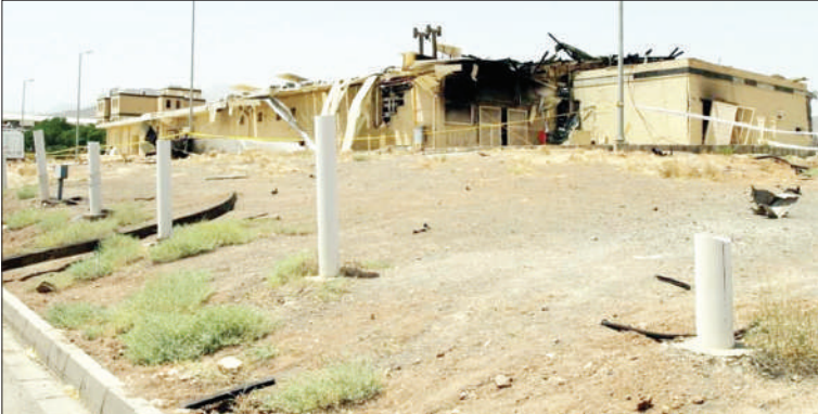
ਤਣਾਅ ਕਾਰਨ ਭਾਅ ਹੋਰ ਤੇਜ਼ ਹੋ ਸਕਦੇ ਹਨ ਤੇ ਕੋਚ ਤੇਲ ਦੀ ਸਪਲਾਈ 'ਚ ਵਿਘਨ ਪੈ ਸਕਦਾ ਹੈ।
